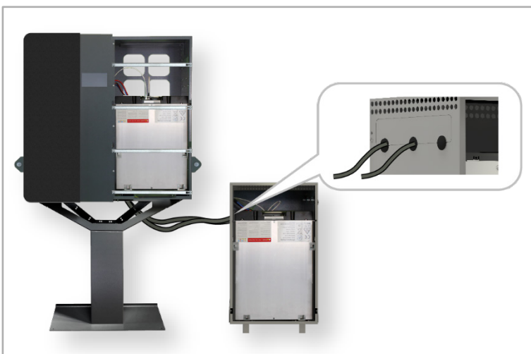
Abb. 77: Batteriekabel zum aufgestellten Batterieschrank führen
