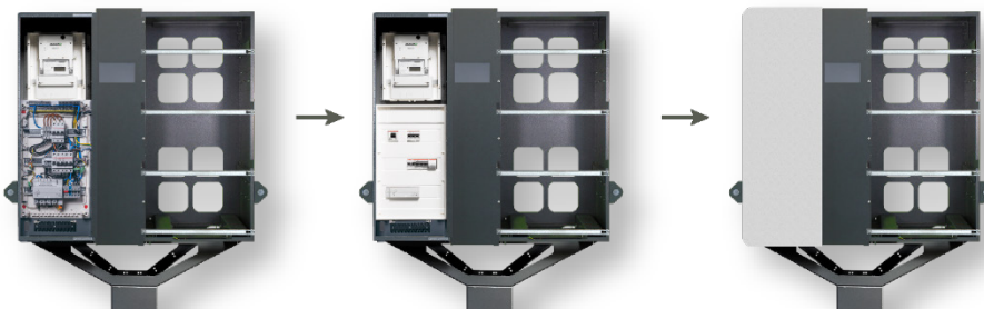
Abb. 67: AC-Raum verschließen (linke Gehäuserhälfte)
