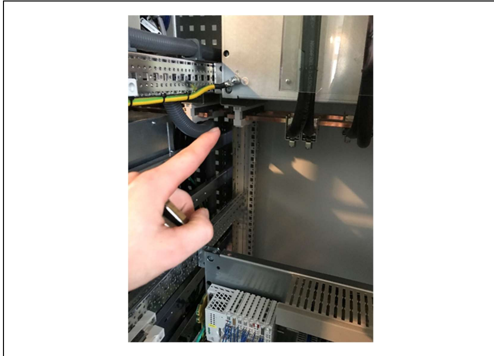
Abb. 22: DC+ und DC- Sammelschiene im Schrank Nr. 3
