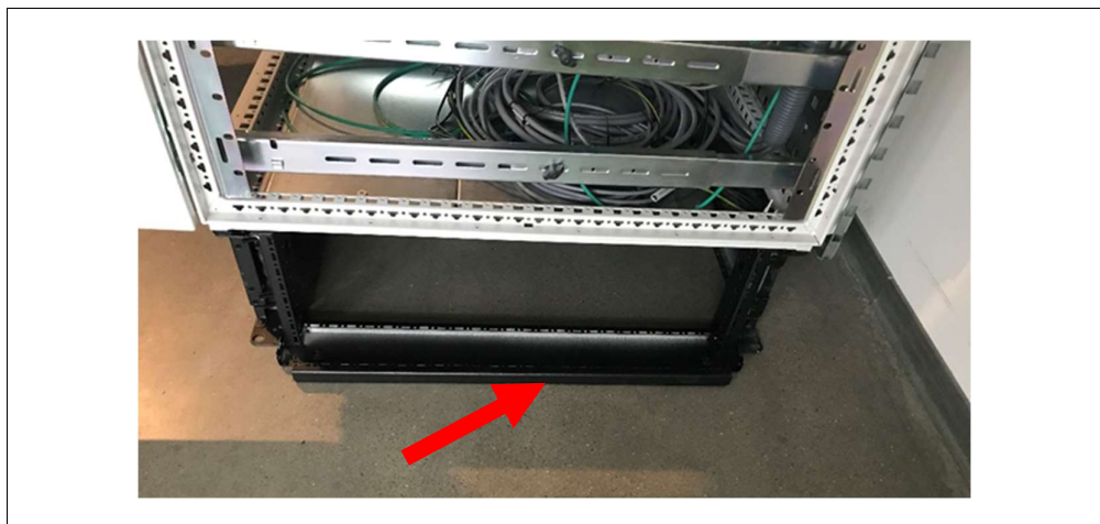
Abb. 6: Schrankverbinder zum Zentrieren
