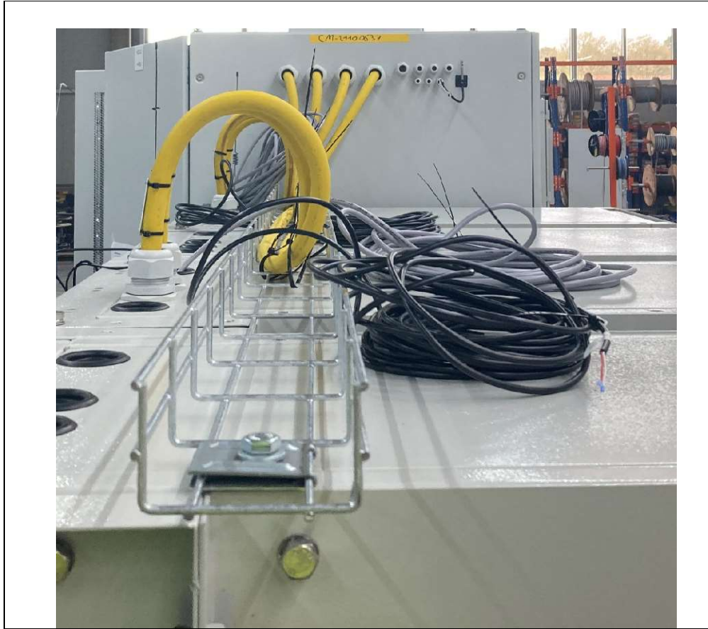
Abb. 32: Beispielhafte Kabeltrasse bei 2-4 Racks
